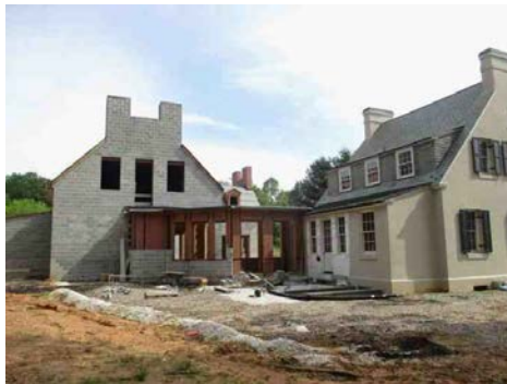
Left Side / Garage Left
